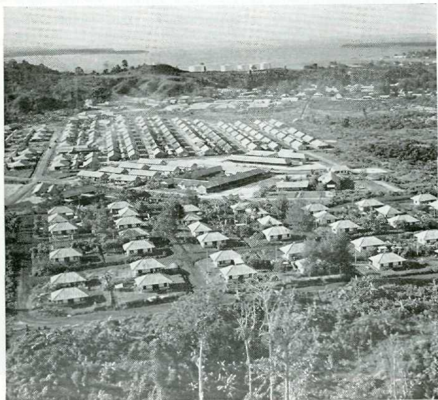
Moderne personeelswoningen te Sorong van de Ned. Nieuw-Guinea Petroleum Maatschappij
