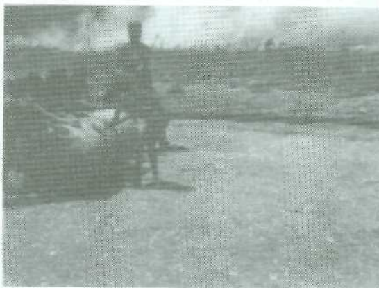
Memadatkan tanah dengan batang pohon araucaria (foto: Nol Hermans).
