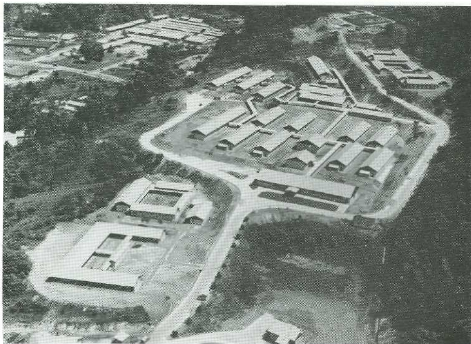
Centraal Ziekenhuis, Hollandia
